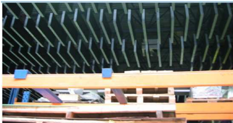
شکل ۵۴- استفاده از جاذب های صوتی جهت کاهش صدا در محیط کار
